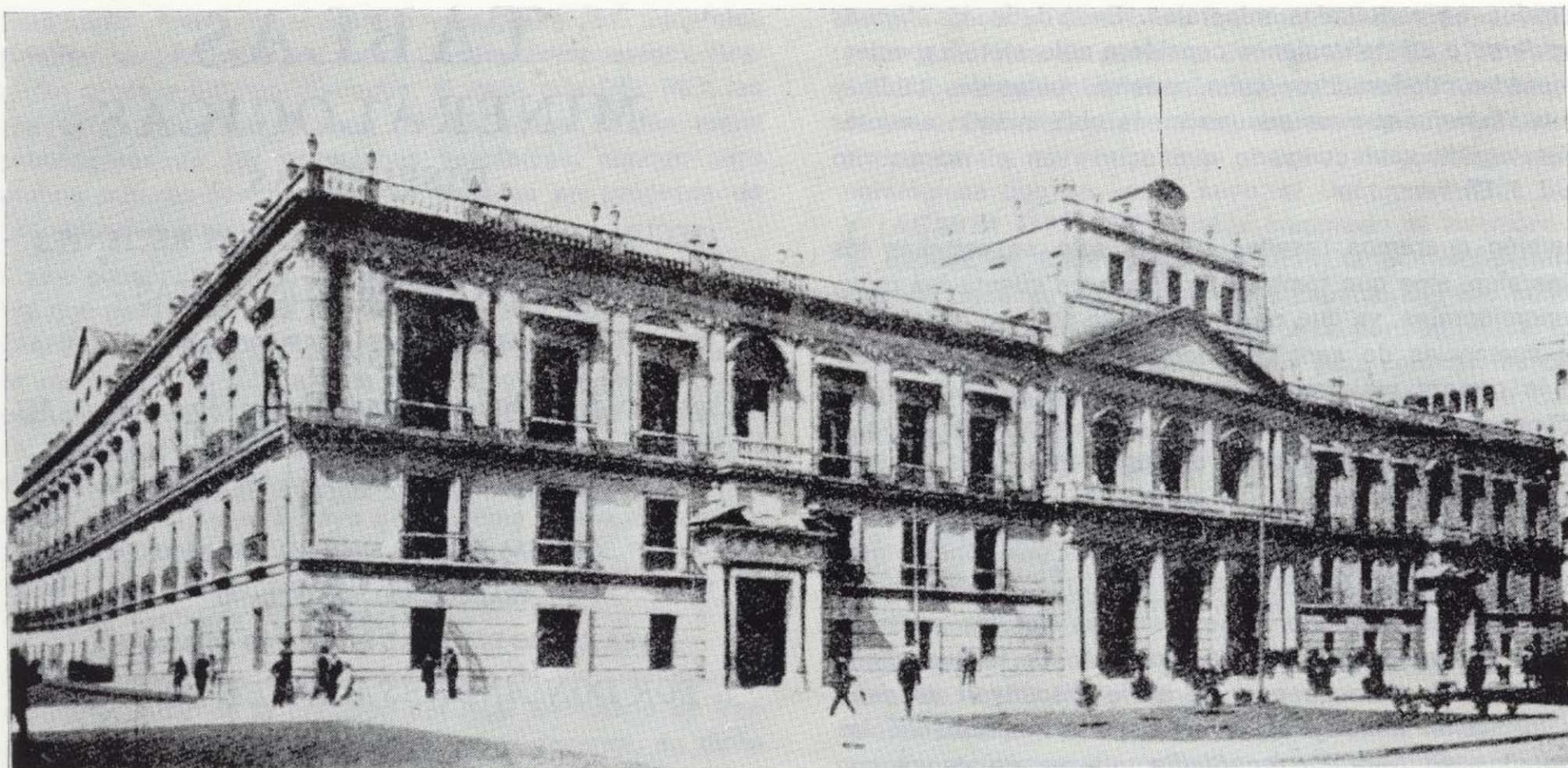
Figura 16.—El Real Seminario de Minería de México, la más antigua Escuela de Ingeniería existente de América, fundada por el ingeniero de minas español Fausto Elhúyar en 1789, iniciándose la docencia en 1792.
